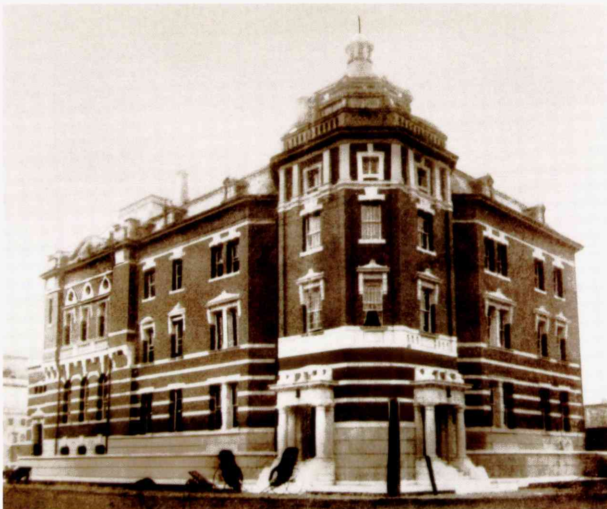
竣工時の旧生命保険会館
